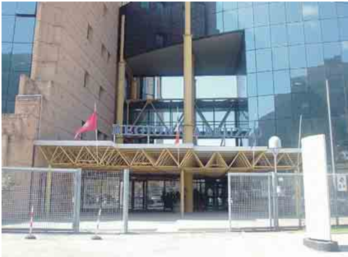
La sede della Regione a palazzo Silone
